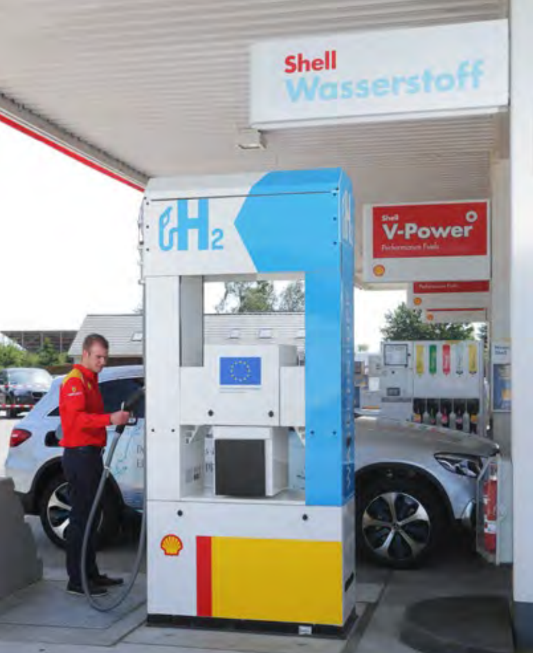
Nördlichste Wasserstofftankstelle Deutschlands: in Handewitt kann seit dem Frühjahr 2019 Wasserstoff getankt werden
